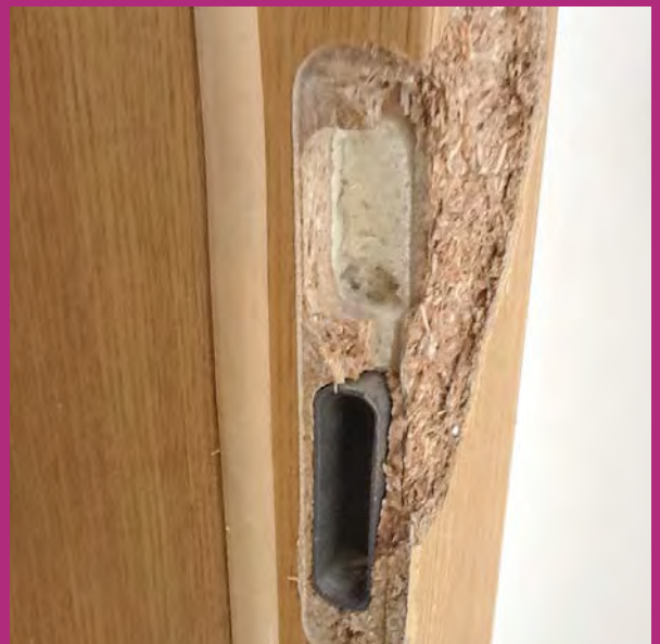
Marco da Porta em aglomerado, sem resistência e a durabilidade exigida da porta
