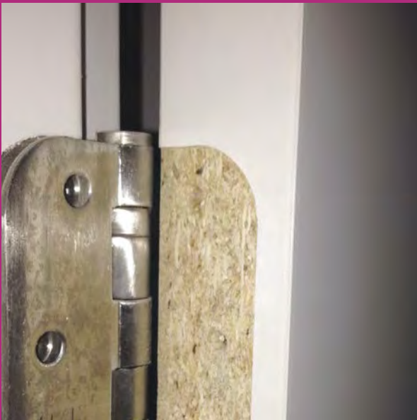
Folha da Porta sem o quadro (simples painel de aglomerado) com baixa vida útil
