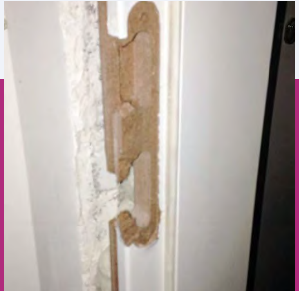
Marco da Porta produzido com MDF de baixa densidade, sem resistência e durabilidade
